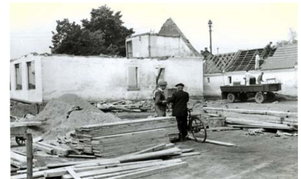
Die Ur-Altschule wurde 1950 abgebrochen
