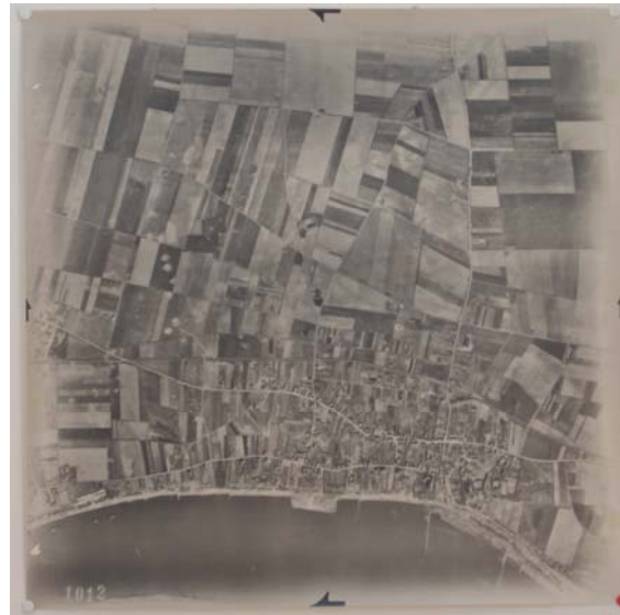
Militär-Luftfoto von ca. 1943 mit zahlreichen Bombeneinschlagtrichter und ein Schützengraben und entlang der Rheinpromenade der Organisation TODT
