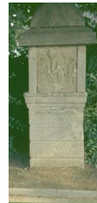
Erster Fußfall. Zustand vor der Restaurierung 1987, von sieben Fußfällen an der Spicher Straße bis Uckendorf, Niederkasseler Straße, gleich hinter den Bahnschienen beginnend
