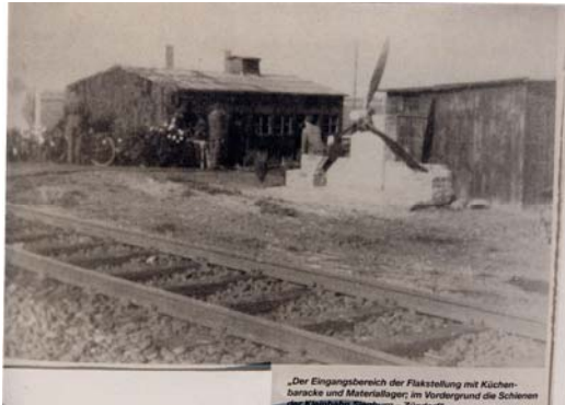
Flakstellung zwischen Niederkassel und Rheidt gegenüber vom Wasserwerk Niederkassel
